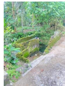
Gambar 14. Jamban di sungai
